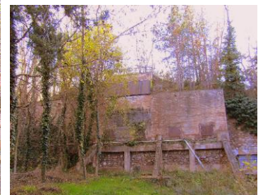
Trémie et gare de départ du câble
