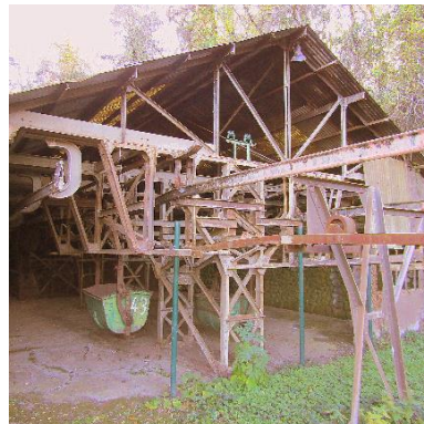
Pour descendre le minerai du lieu d'extraction dans la vallée, près de La Bastide, un transporteur aérien fut construit.
