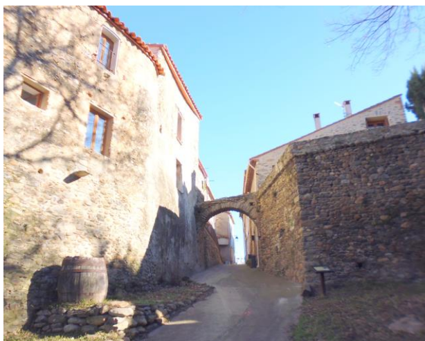
Aqueduc permettant de conduire les eaux du canal à l'Hort du Priorat
